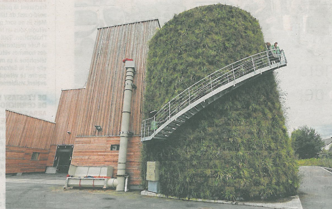
Plus de 6 000 plantes tapissent la cuve de stockage d'eau anti-incendie de l'entreprise. PHOTO LUDOVIC MAILLARD
