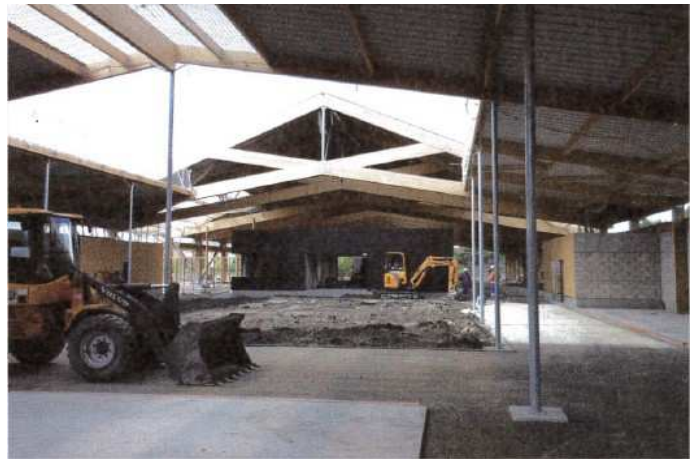
Vue d'ensemble des deux parties de la charpente sur deux niveaux
