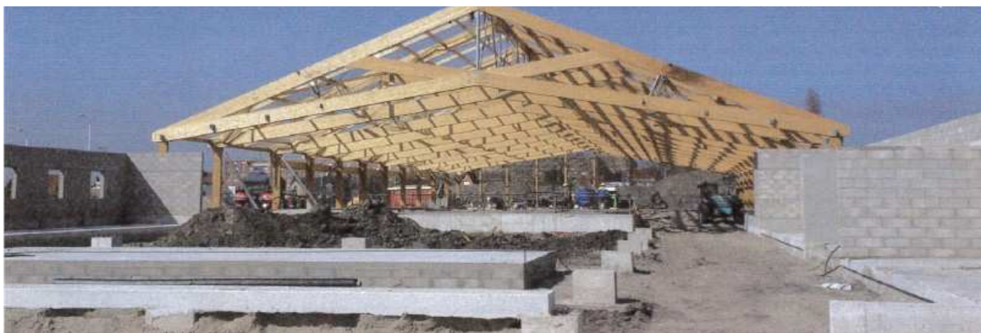
La structure poteaux et charpente lamellé-collé a nécessité huit semaines de pose.
