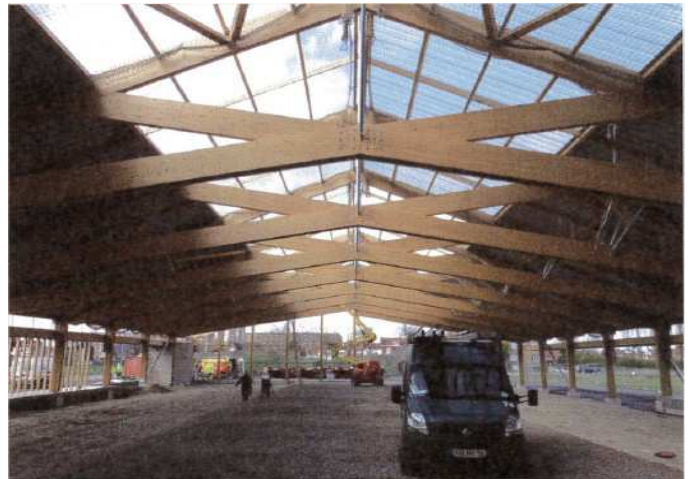
Une structure composée de fermes ciseaux d'une portée de 30 mètres sur poteaux bois pendulaires pour le centre équestre de Grande-Synthe
