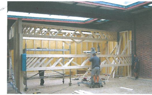
Une « boîte » composée de modules de murs à ossature bois de 140 cm x 60 cm soutient les poutres et s'insère dans l'enveloppe de briques existante.
